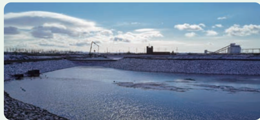
胜利能源蓄水工程
