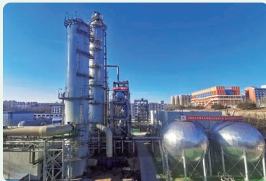
锦界能源CCS示范工程项目现场
