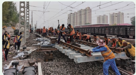
专用线铺轨作业现场
