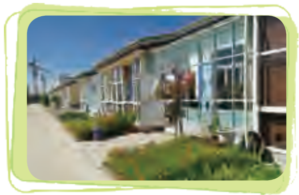
在青海省剛察縣援建的沙柳河鎮遊牧民定居 小區配套基礎設施建設項目
