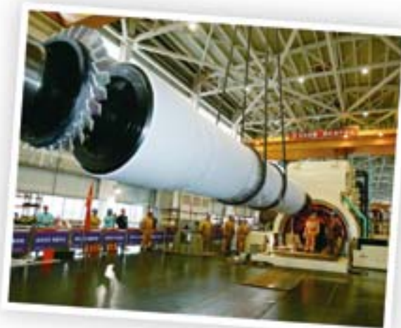
发电机组 转子吊装
