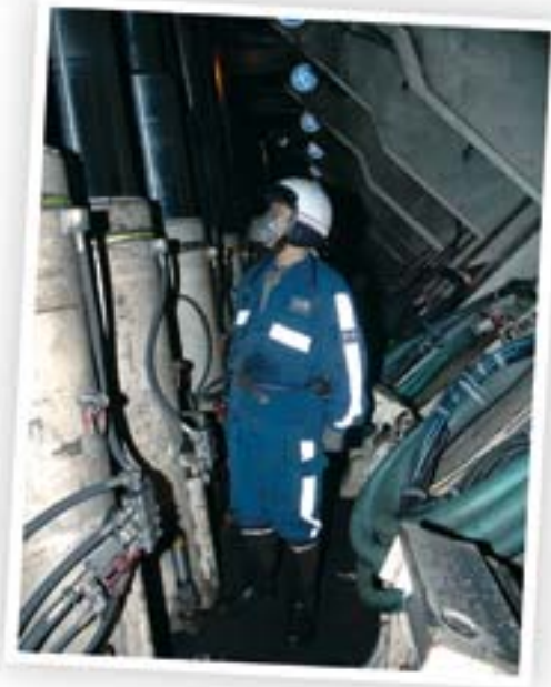
工作人员检查 液压支架
