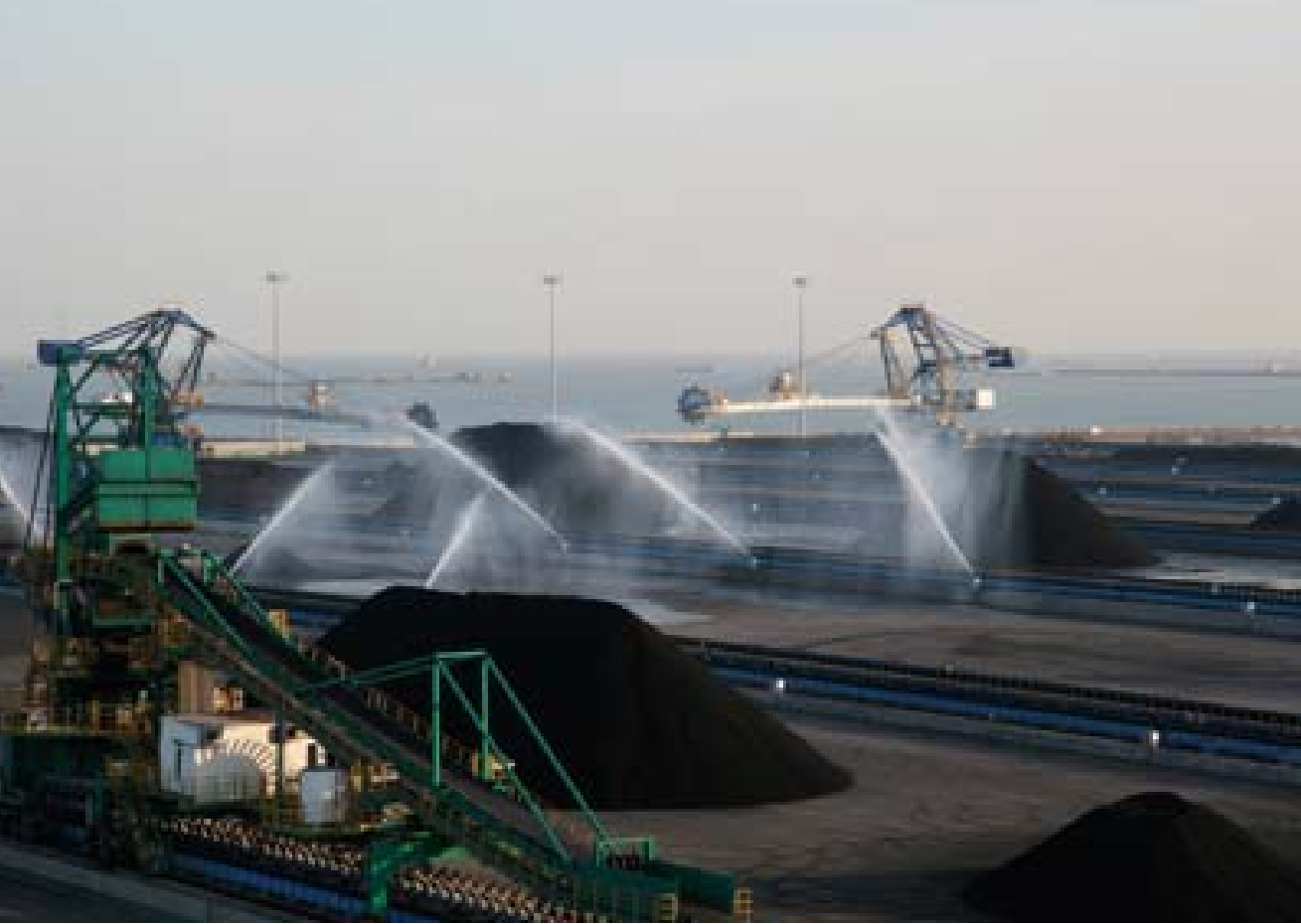
神华天津煤码头洒水降尘设施
